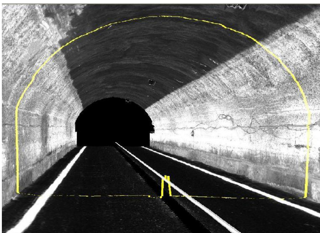
Vista tridimensionale della restituzione laser scanner
